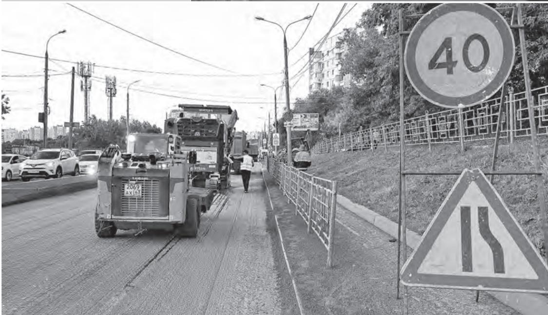
они ведутся по погоде. В частности, фрезерование не останавливается и при незначительных осадках. При этом укладка асфальтобетонной смеси выполняется только в сухую погоду.
