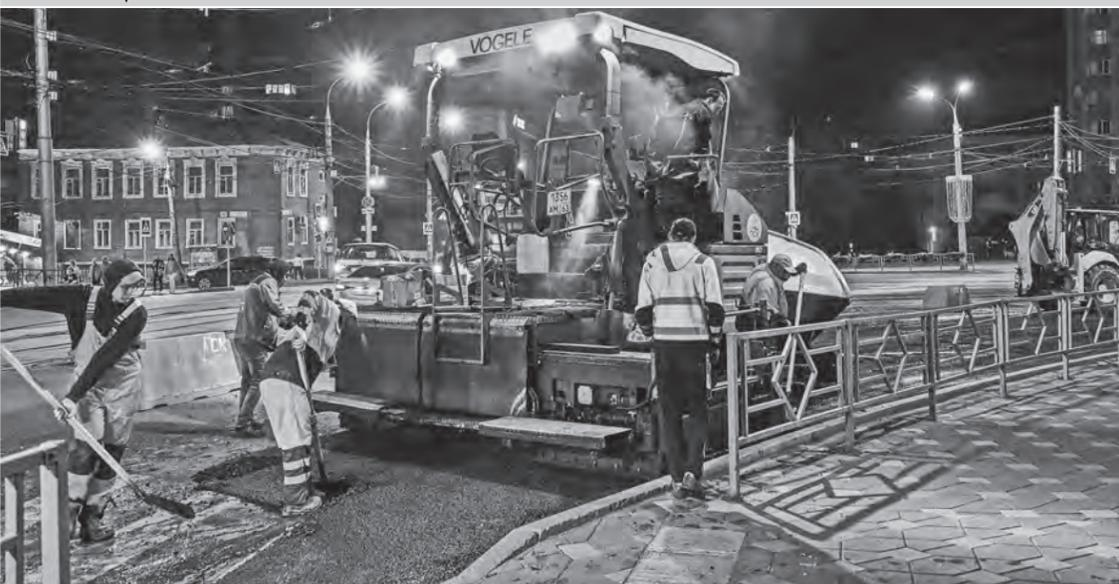
нено наполовину. Там, где уже удалено изношенное полотно и восстановлены колодцы, основание избавляют от пыли и грязи, осуществляется розлив битумной эмульсии. После этого выполняется укладка. Применяется асфальтобетонная смесь ШМА-16 на полимерно-битумном вяжущем. Это новая марка, которая хорошо зарекомендовала себя. Работы подрядчик производит от борта до борта, метр за метром создавая комфортные и безопасные условия
